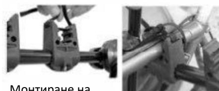
Монтиране на носещите ремъци
