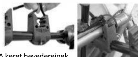
A keret hevedereinek felszerelése
